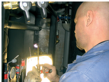
Maalämpökompessorinputkeistonhitsaus- operaatio, hitsaamassa Tero Ruottinen.
