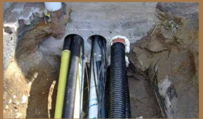
LV-remontin yhteydessä tehtiin varaukset tulevaan ilmastointiremonttiin
