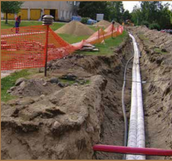
Päärakennuksen LV-remontti oli vuoden suurin investointi
