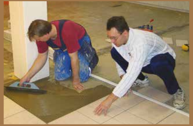
Pertti Gustavsson ja Janne Järvensivu laatoittivat Ritalan alakerran keskiluokan
