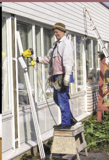
PERUSKORJAUSTA ILPO PÖLLÄSEN JOHDOLLA
