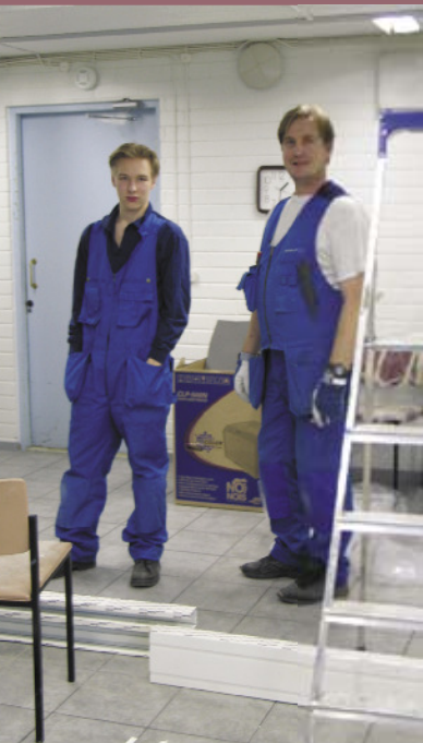
VIRTAVELJET SÄHKÖ- JA VERKKOTÖISSÄ
